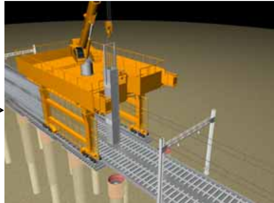
ハーフプレキャスト柱の建込み，柱の場所打ちコンクリートを打設
