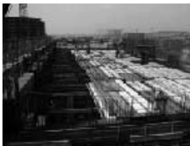
写真-1 住戸内床のハーフPCa板架設
