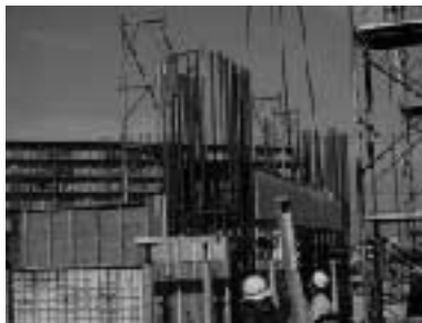
写真-3 PCa大梁の架設
