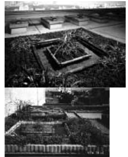
上 / ピオトープ型屋上緑化 下 / 屋上緑化実験
